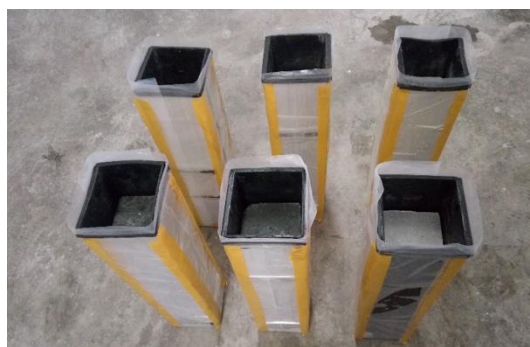
照片 7 模具防漏水处理
