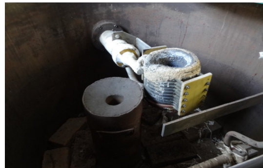
照片3 真空炉内部
