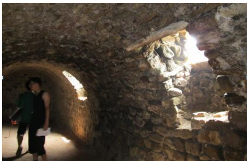
照片5 现场勘查照片(杜辉)
