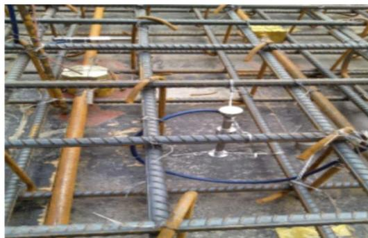
照片9 工地埋设测试仪器
